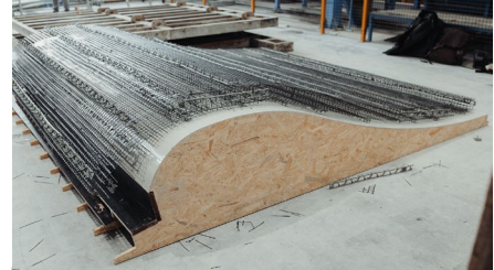
Für den Bau der Welle wurde u.a. Carbon-Recyclingbeton eingesetzt. Bild: Matthias Leo / THA
